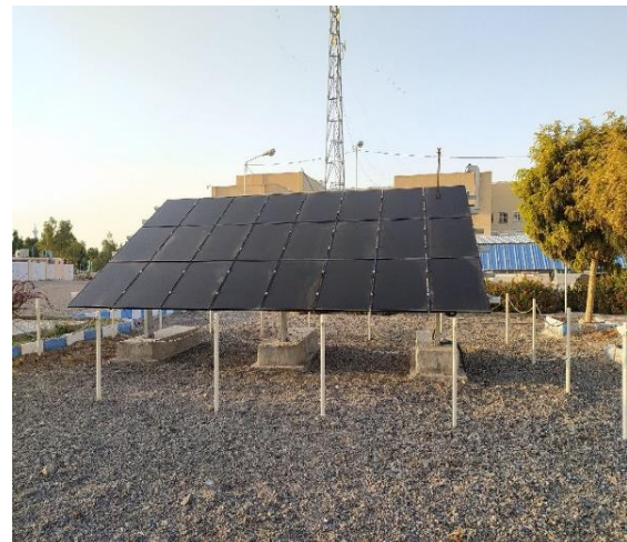
شکل ۱. سامانه ۳ کیلوواتی فوتوولتائیک CIGS متصل به شبکه دانشگاه ولی عصر (عج) رفسنجان.
